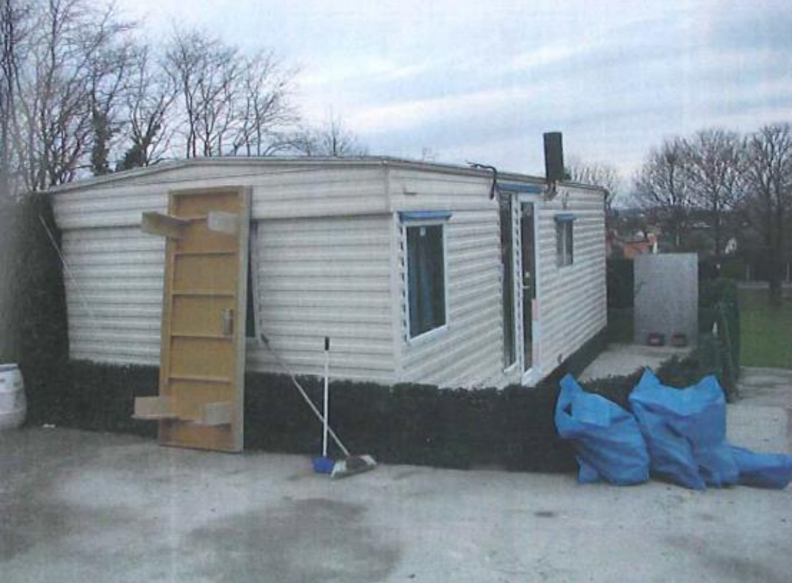
antes da demolición
