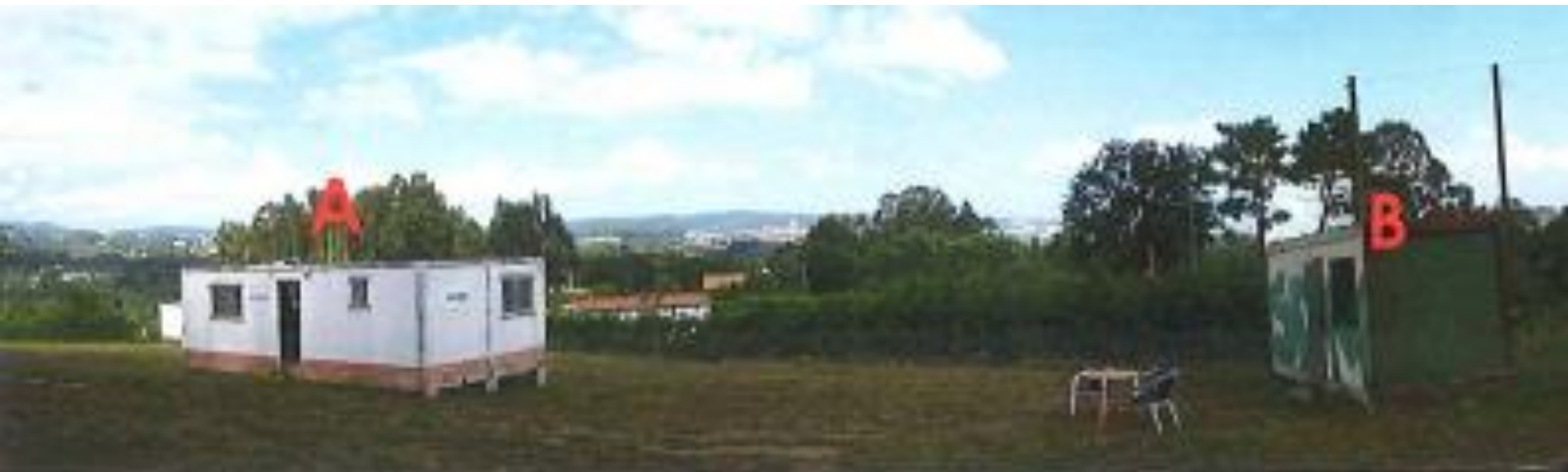
despois da demolición
