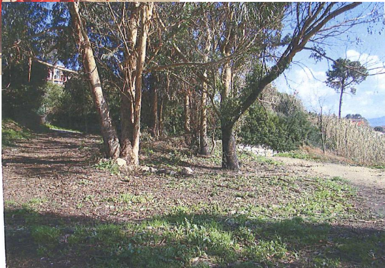
despois da demolición
