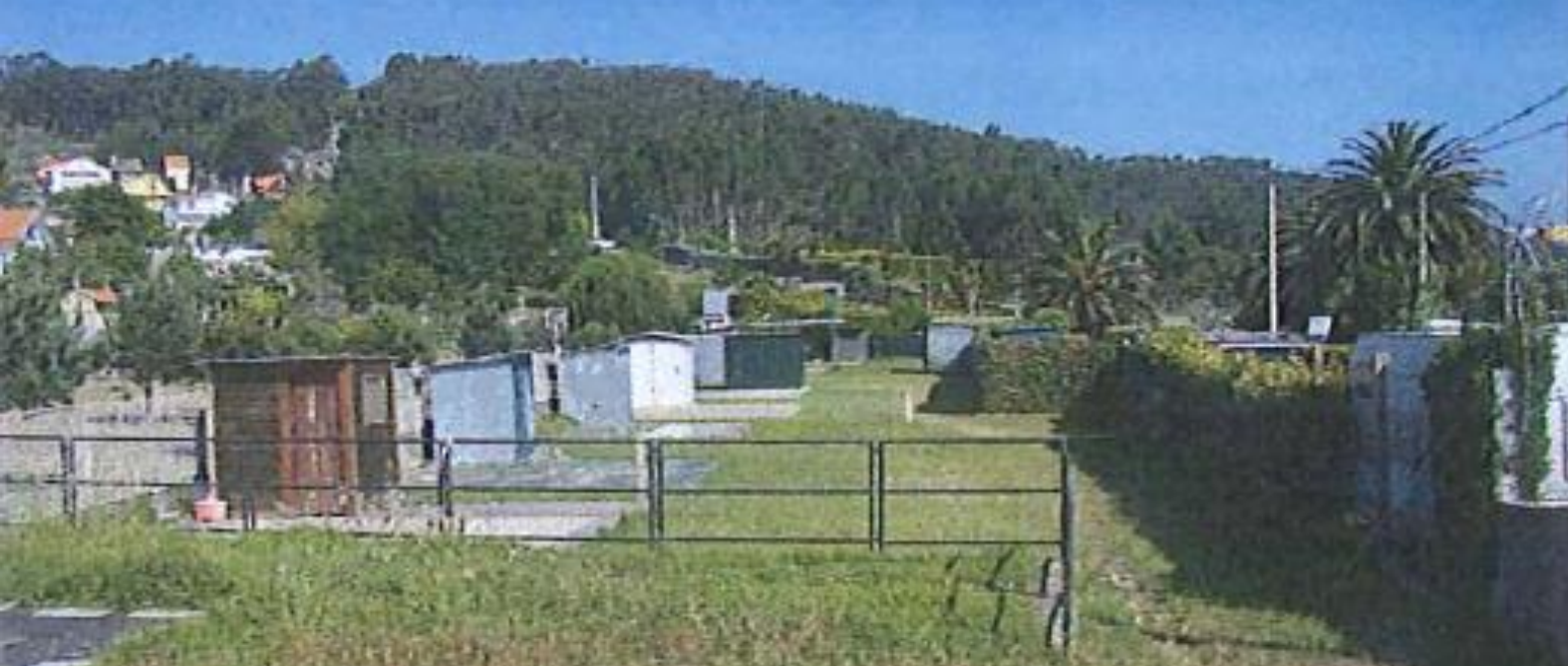
antes da demolição
