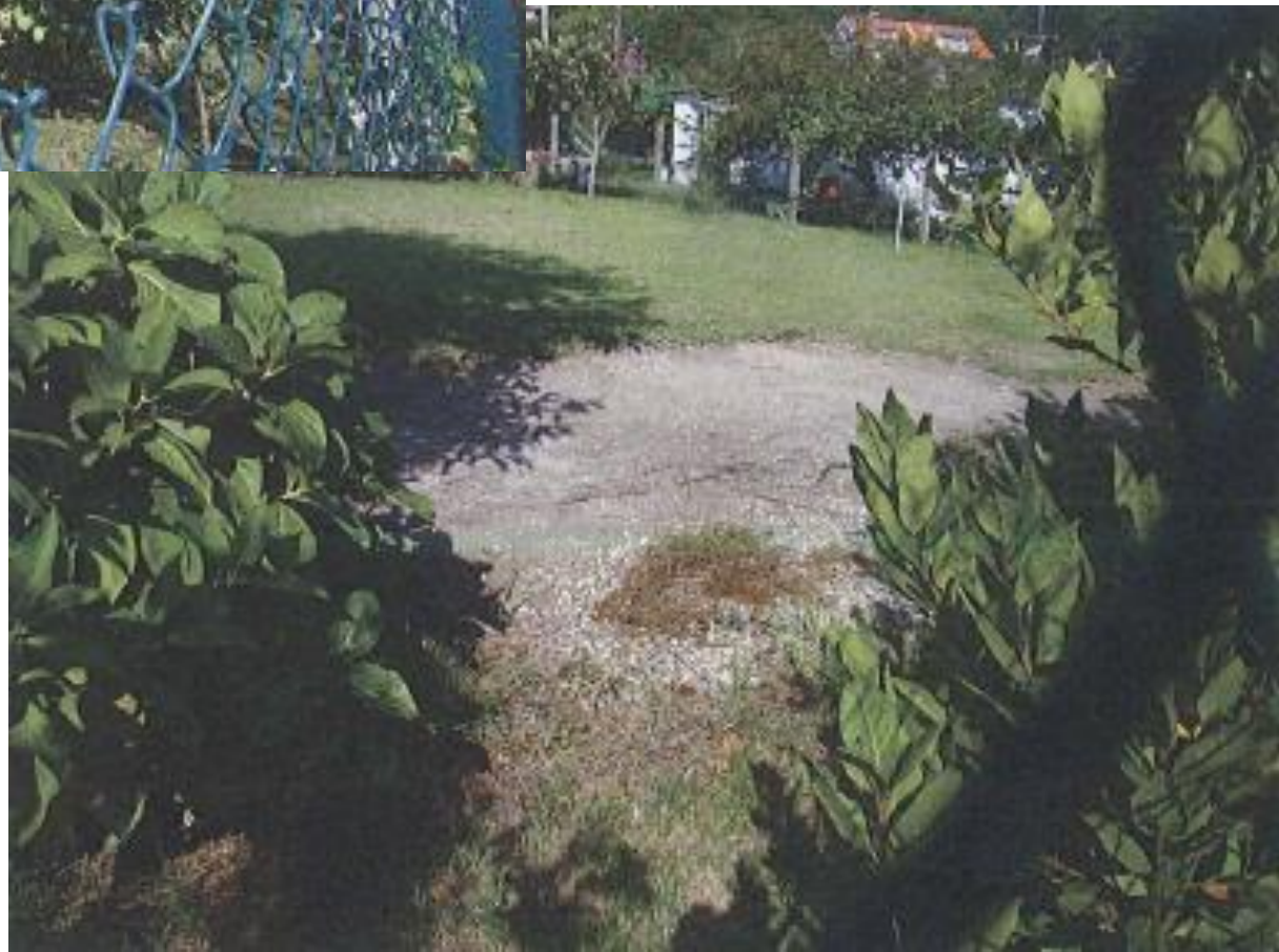
despois da demolición
