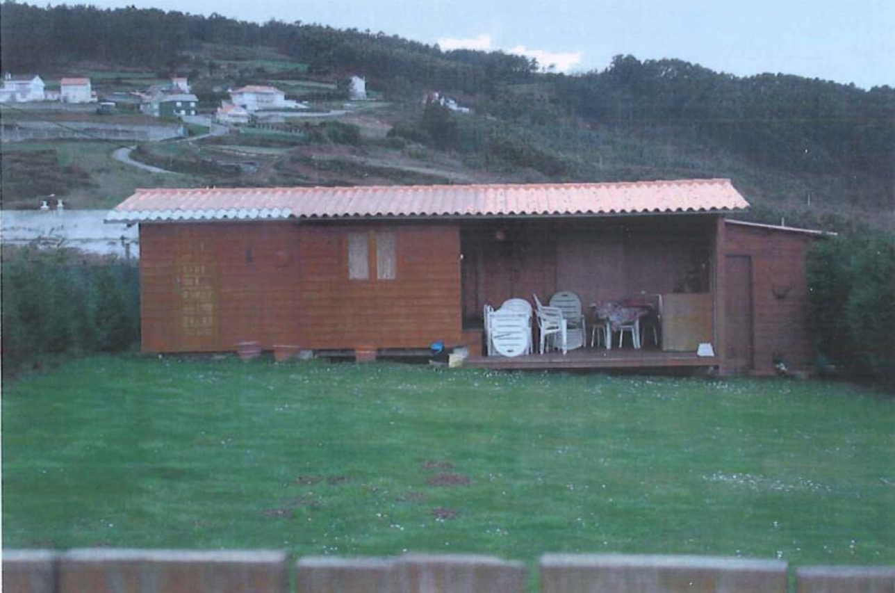
antes da demolición
