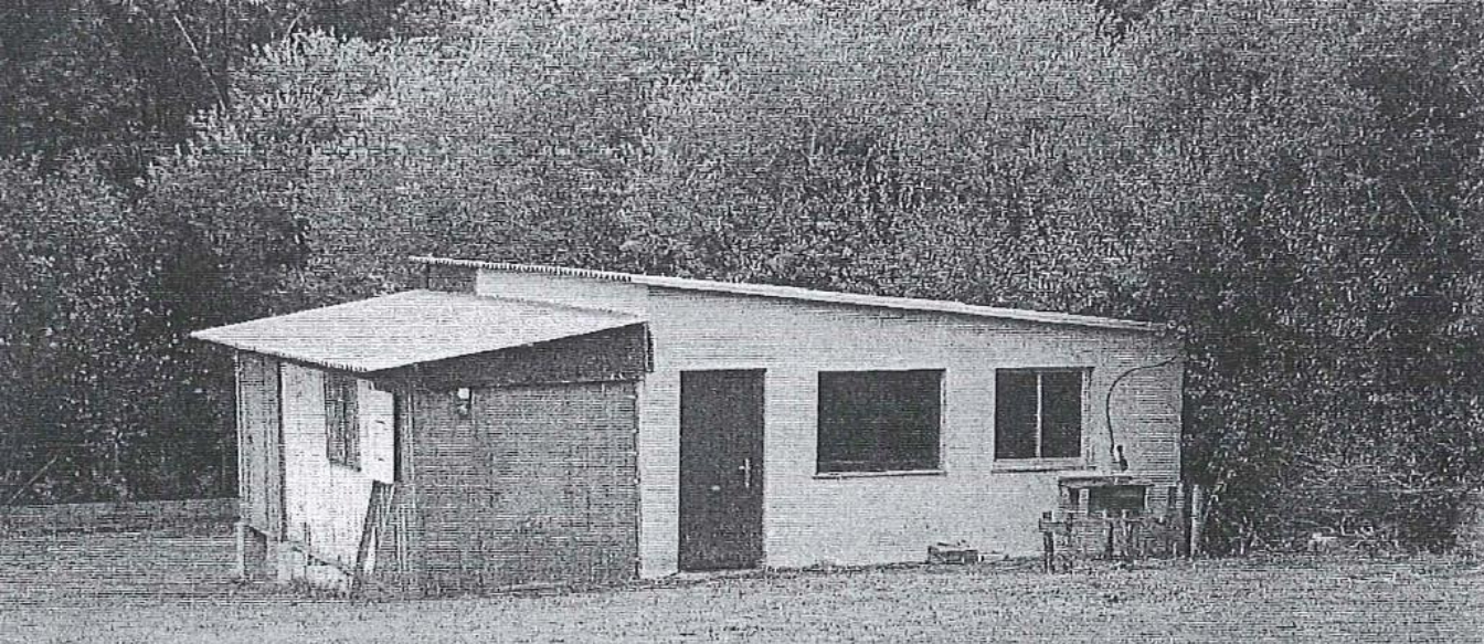
antes da demolición
