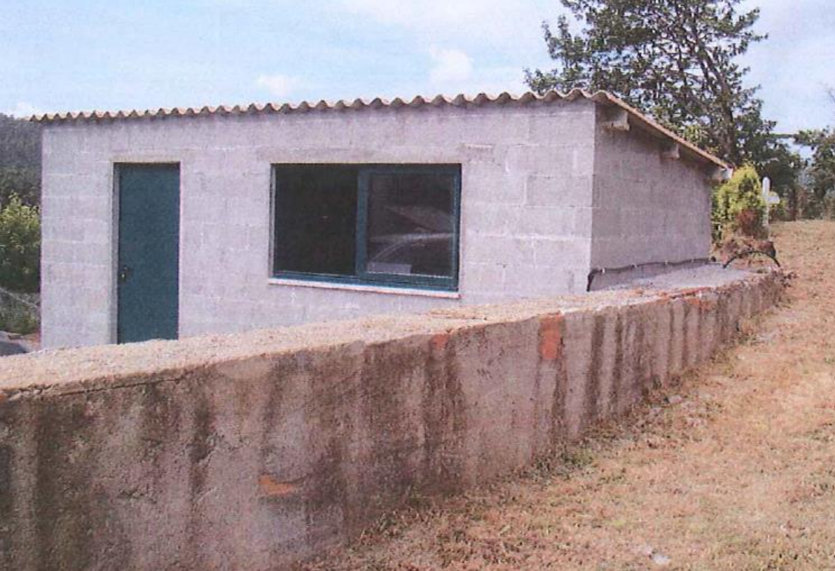
antes da demolición
