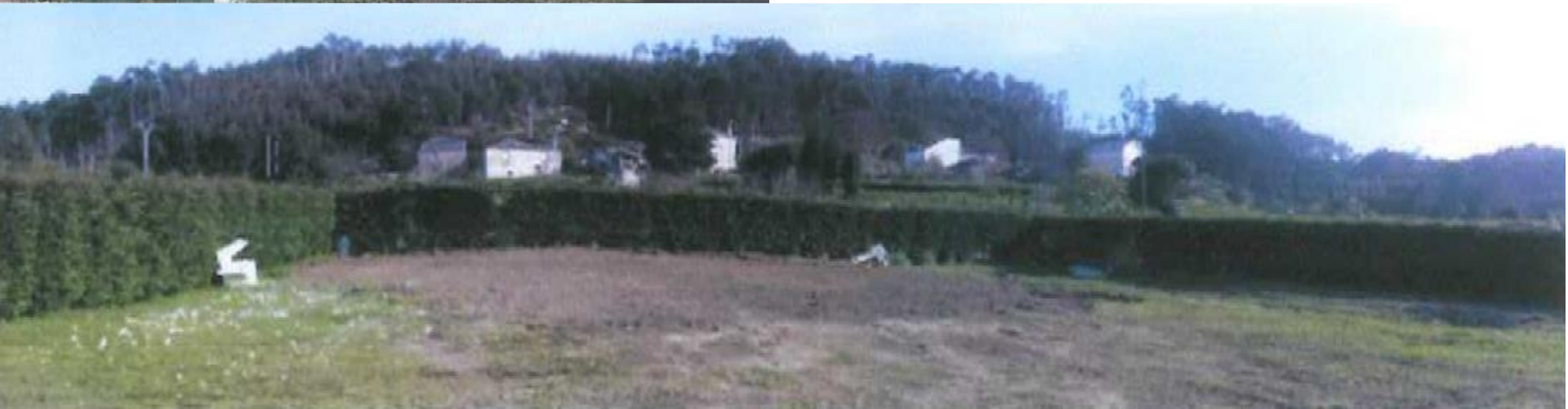
despois da demolición
