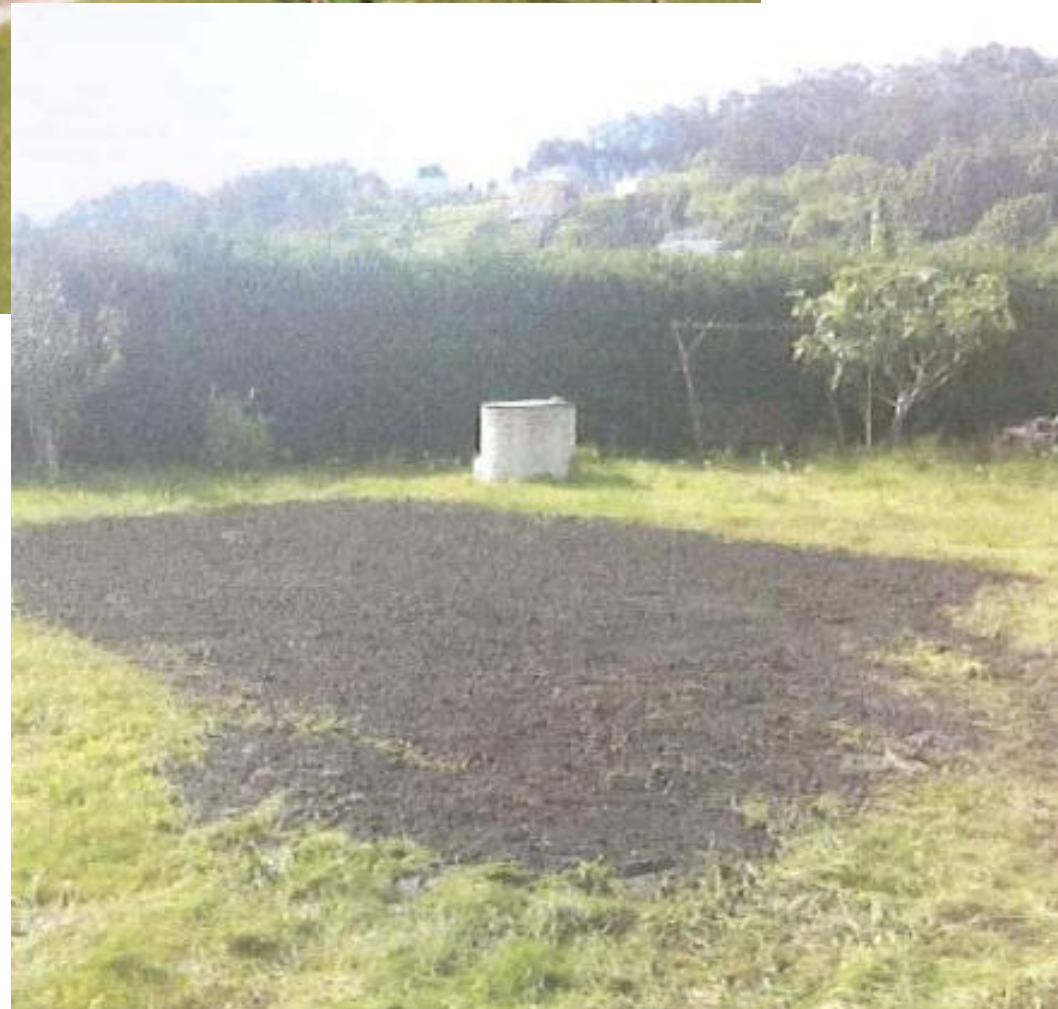
despois da demolición
