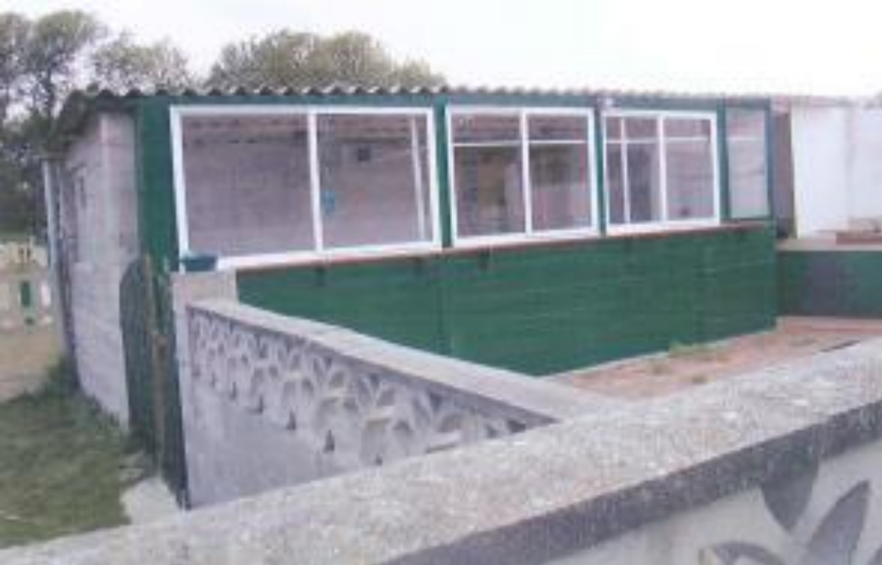
antes da demolición
