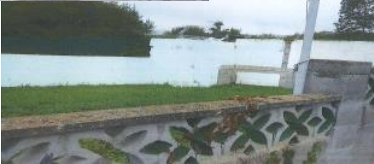
despois da demolición
