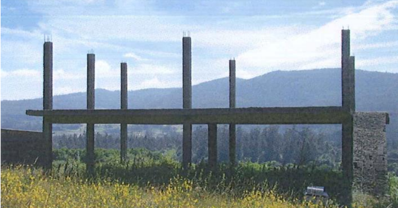
antes da demolición
