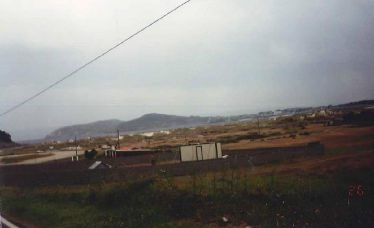
antes da demolición
