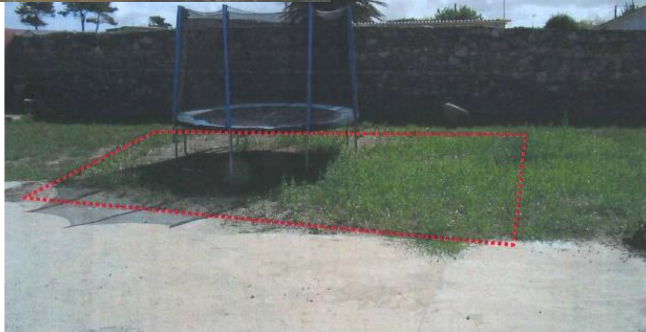
despois da demolición
