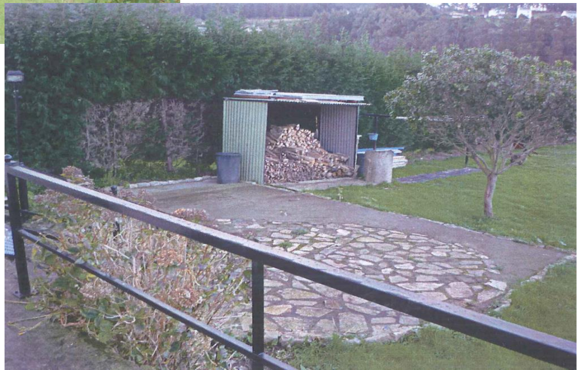
despois da demolición
