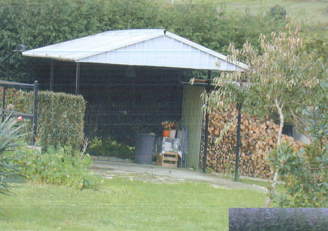
antes da demolición
