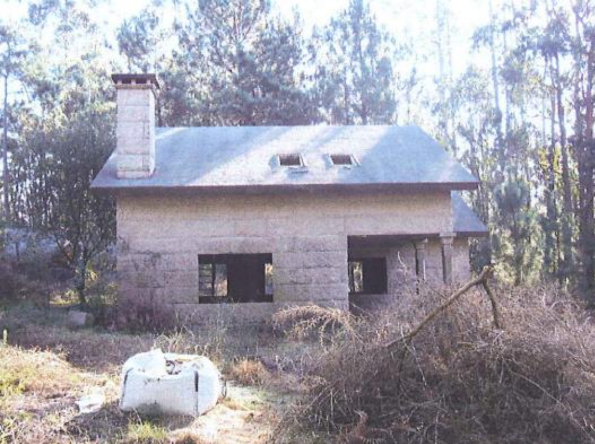
antes da demolición
