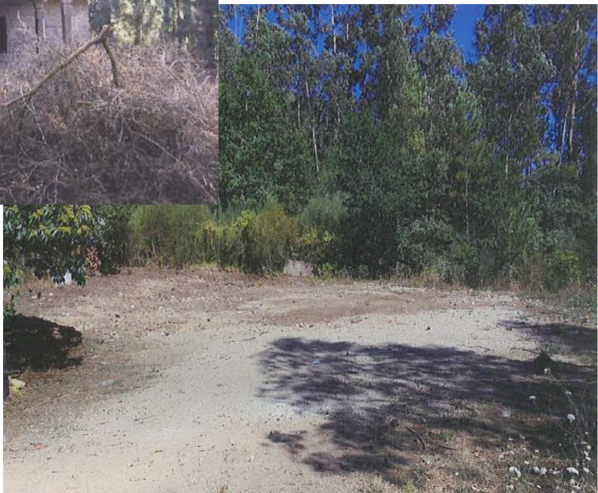
despois da demolición
