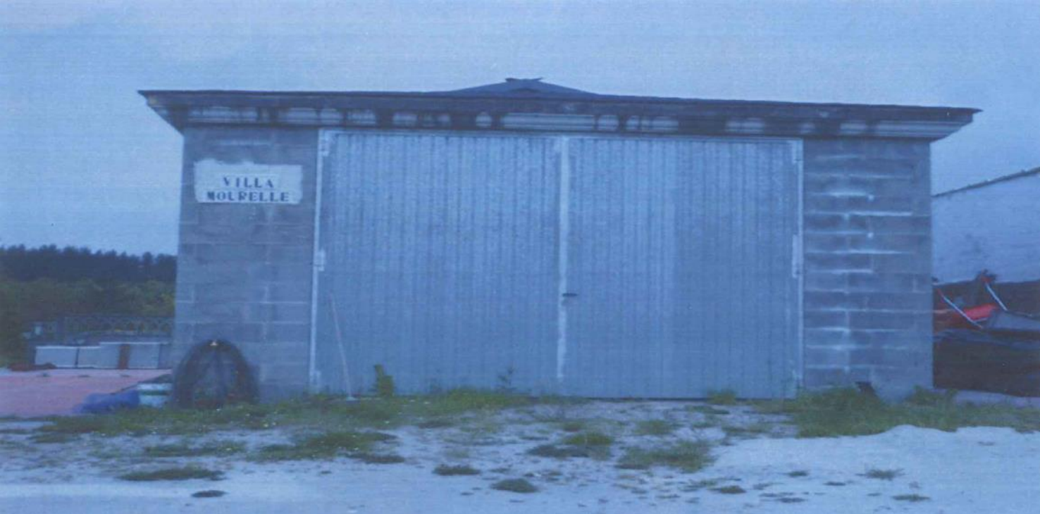
antes da demolición
