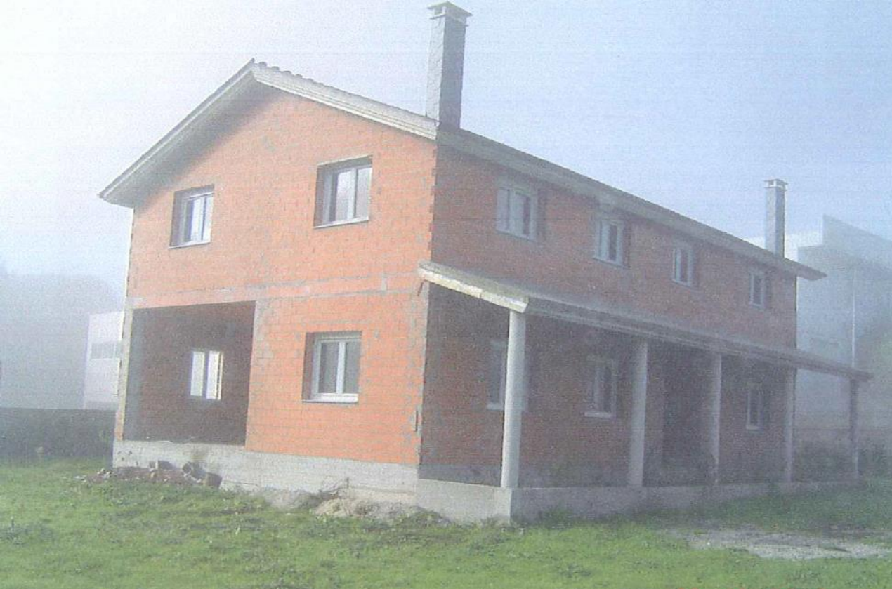
antes da demolición
