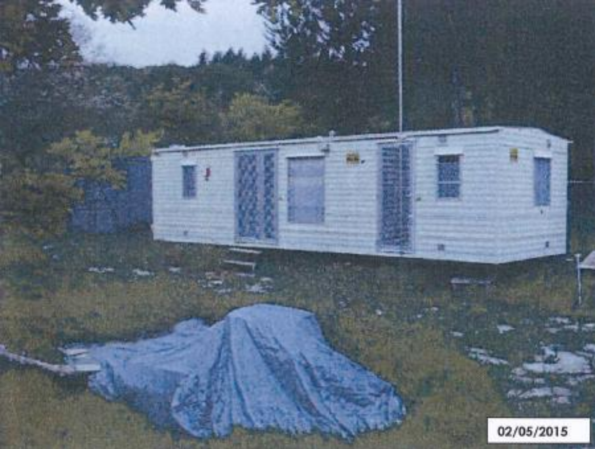
antes da demolición
