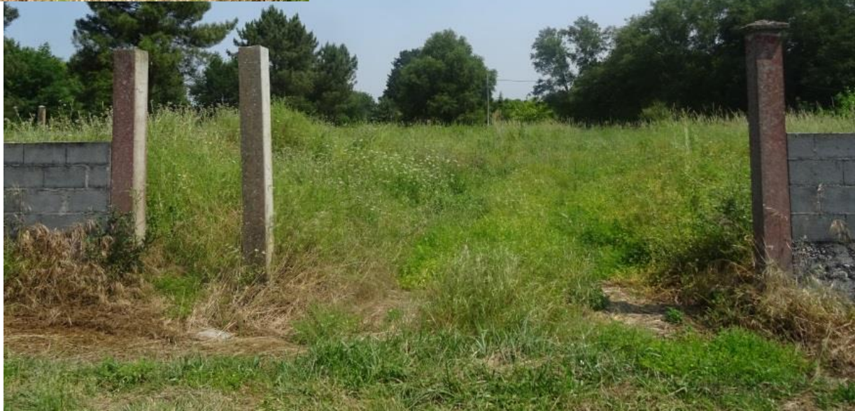
despois da demolición
