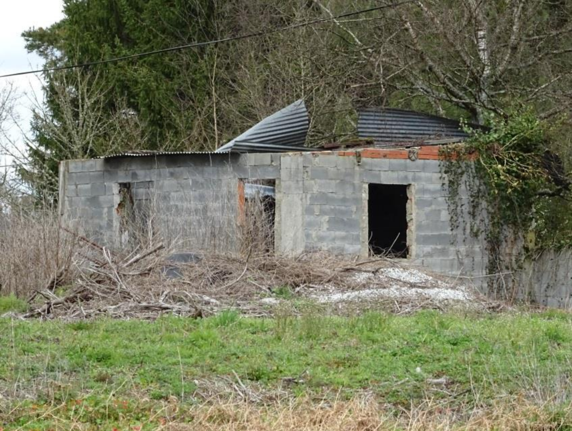
antes da demolición
