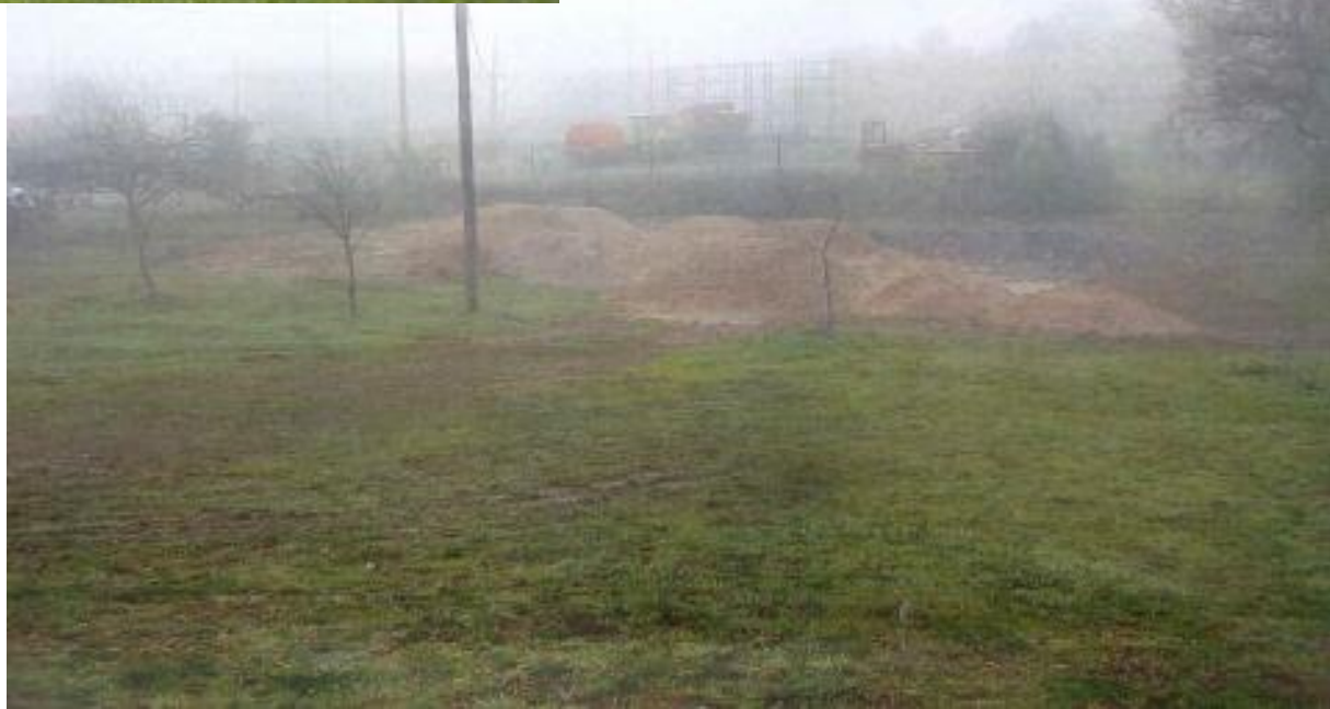
despois da demolición
