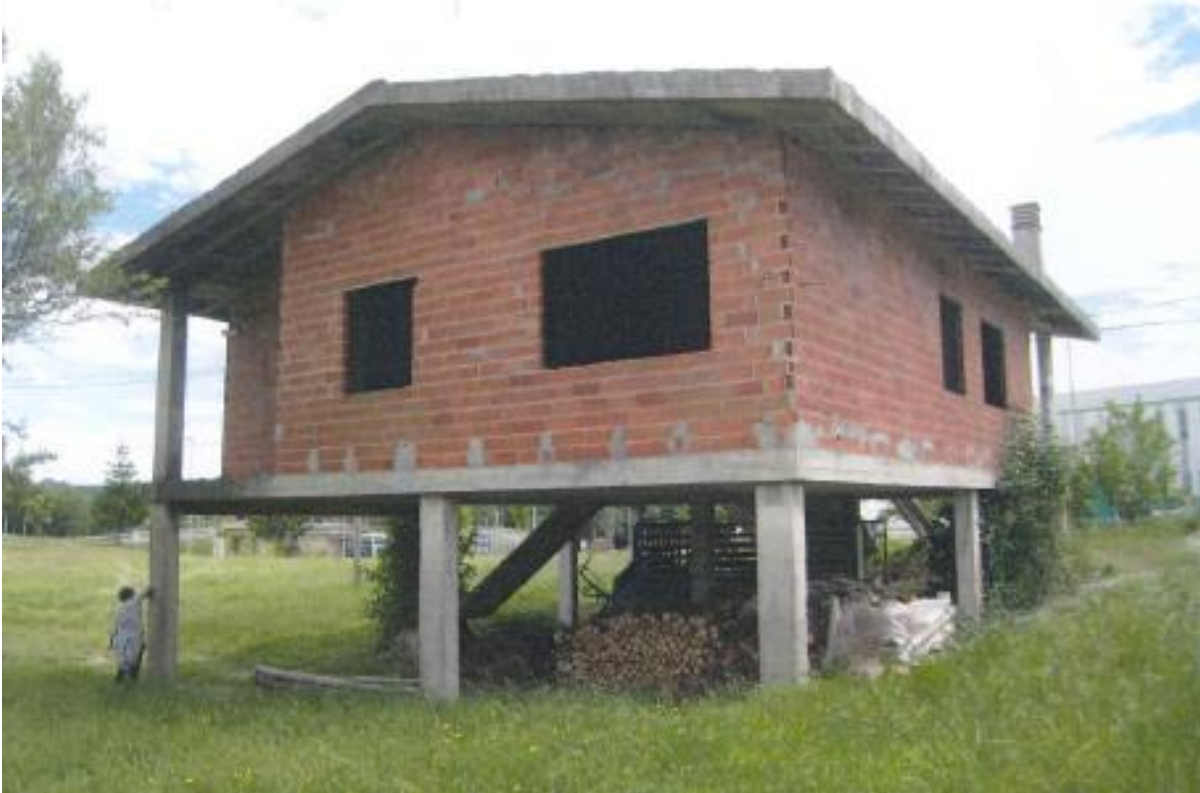
antes da demolición
