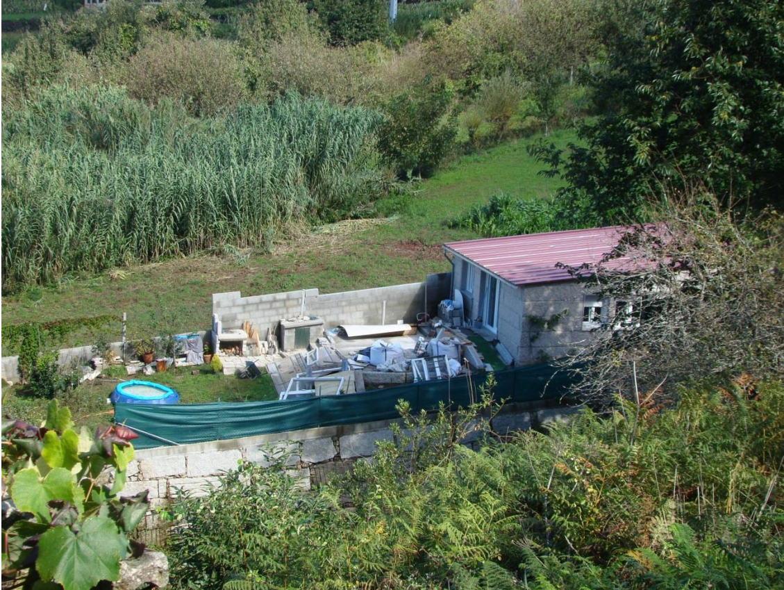
antes da demolición
