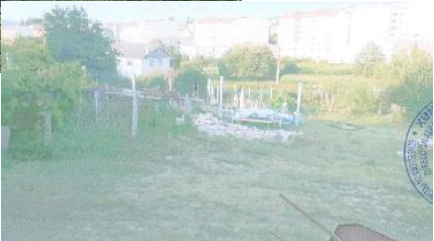
despois da demolición
