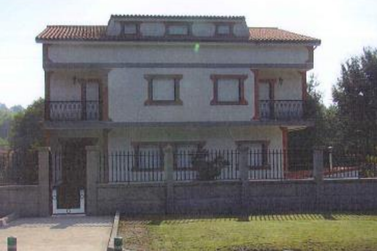
antes da demolición
