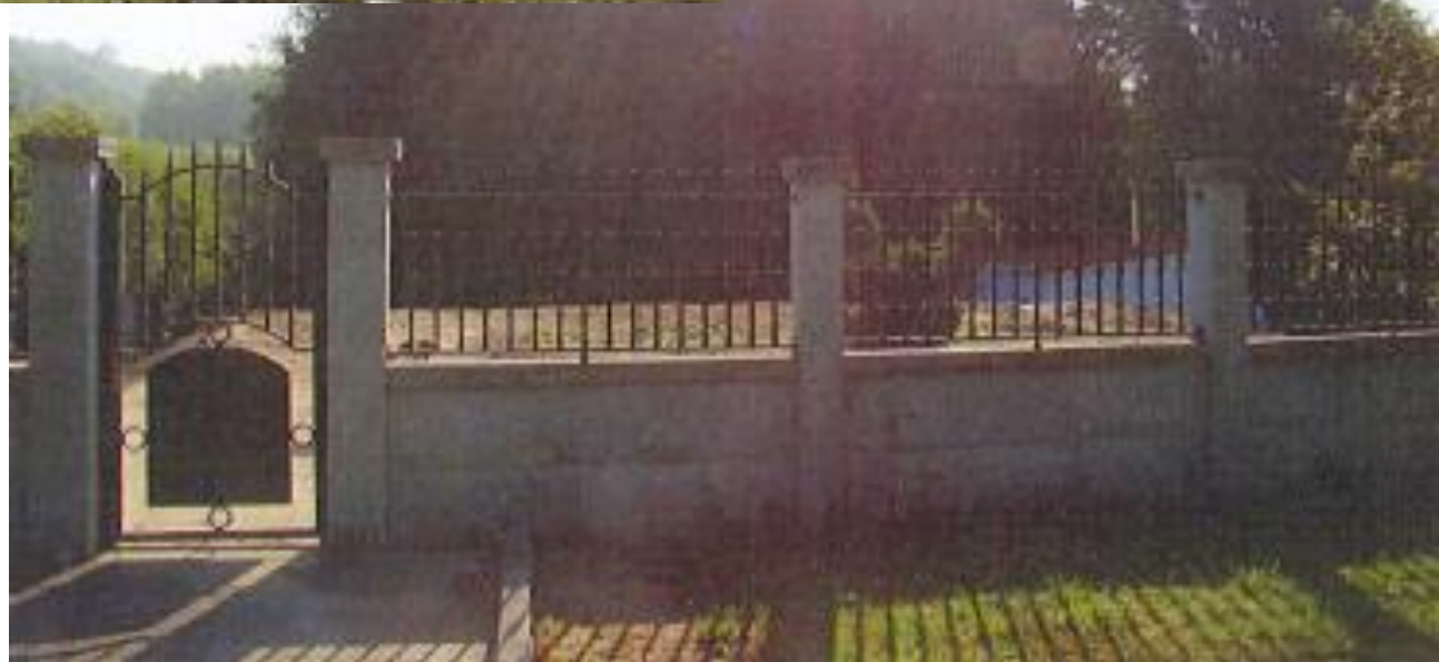
despois da demolición
