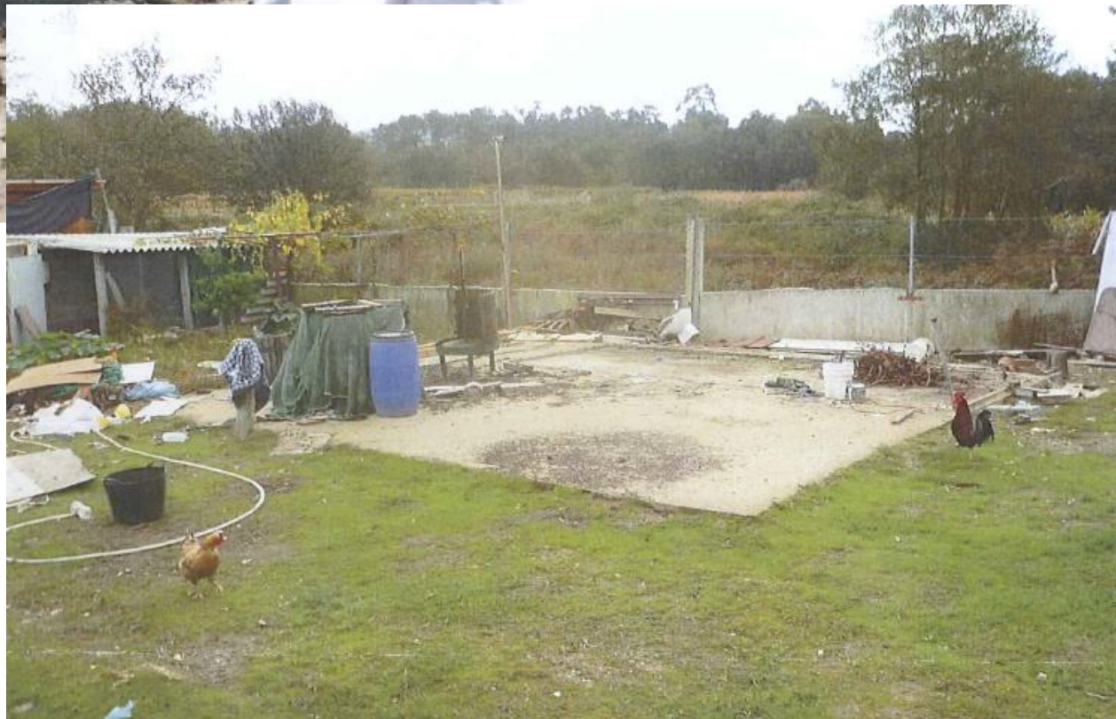
despois da demolición
