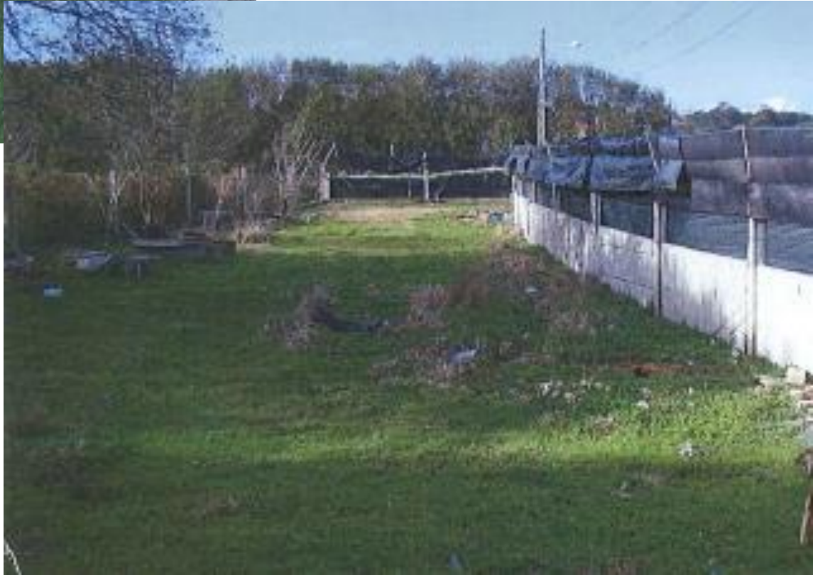
despois da demolición
