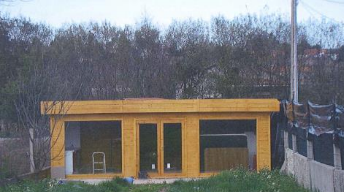
antes da demolición
