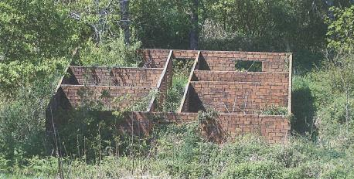
antes da demolición
