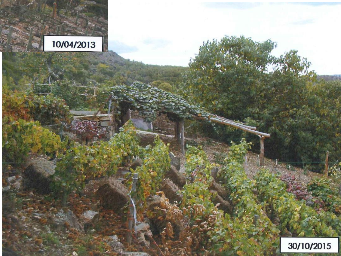
despois da demolición
