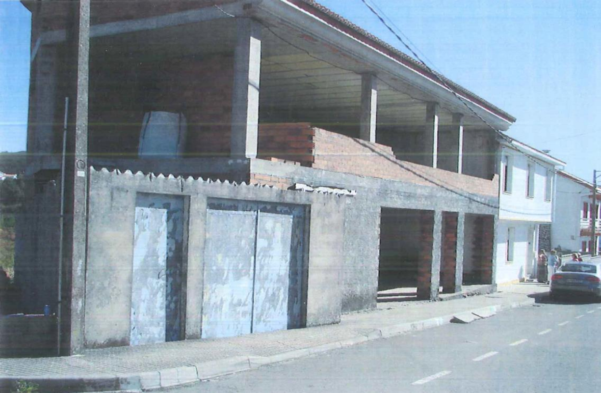
antes da demolición
