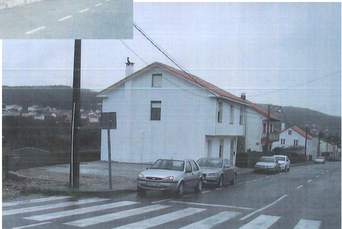
despois da demolición
