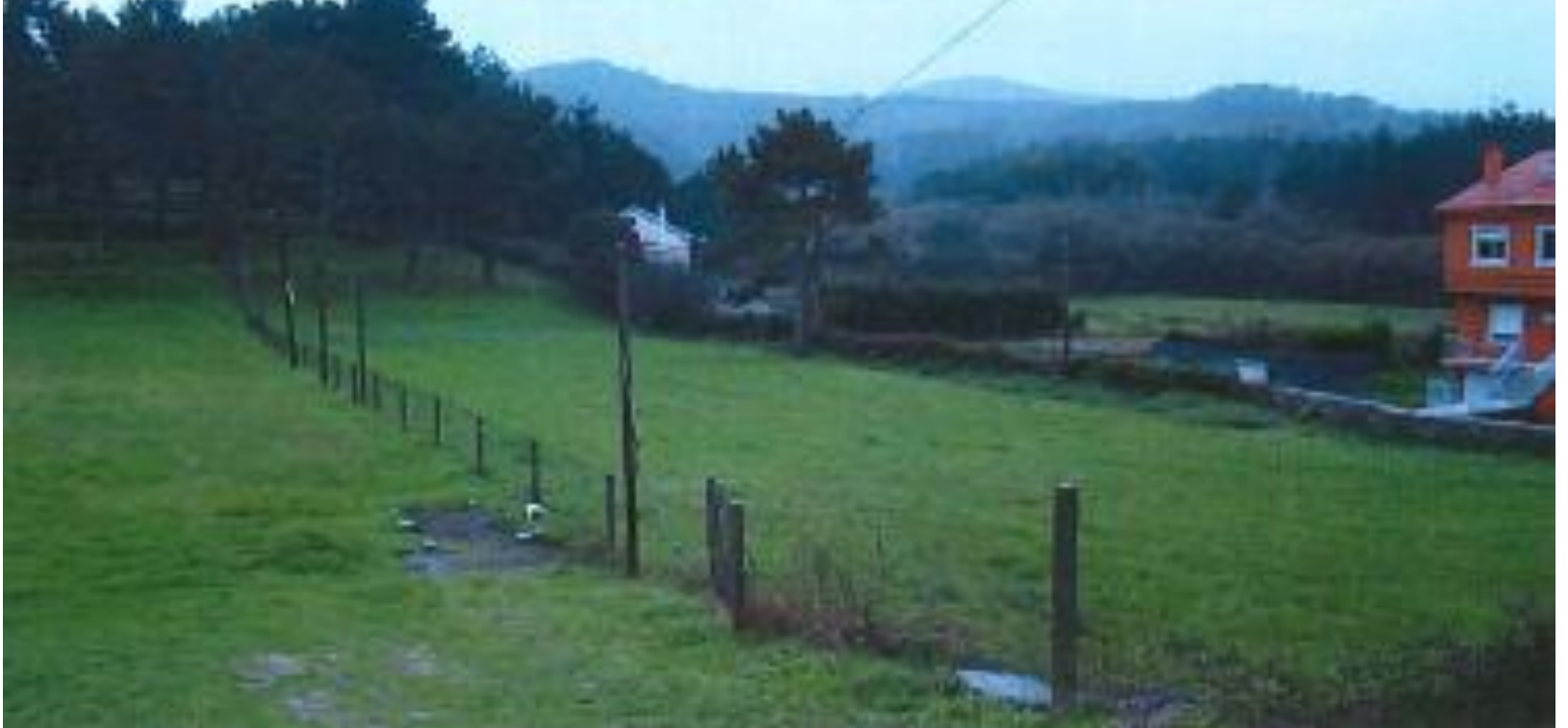
despois da demolição
