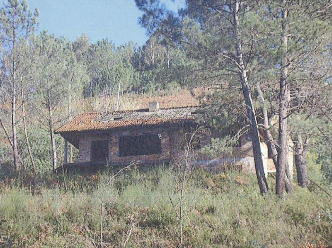
antes da demolición
