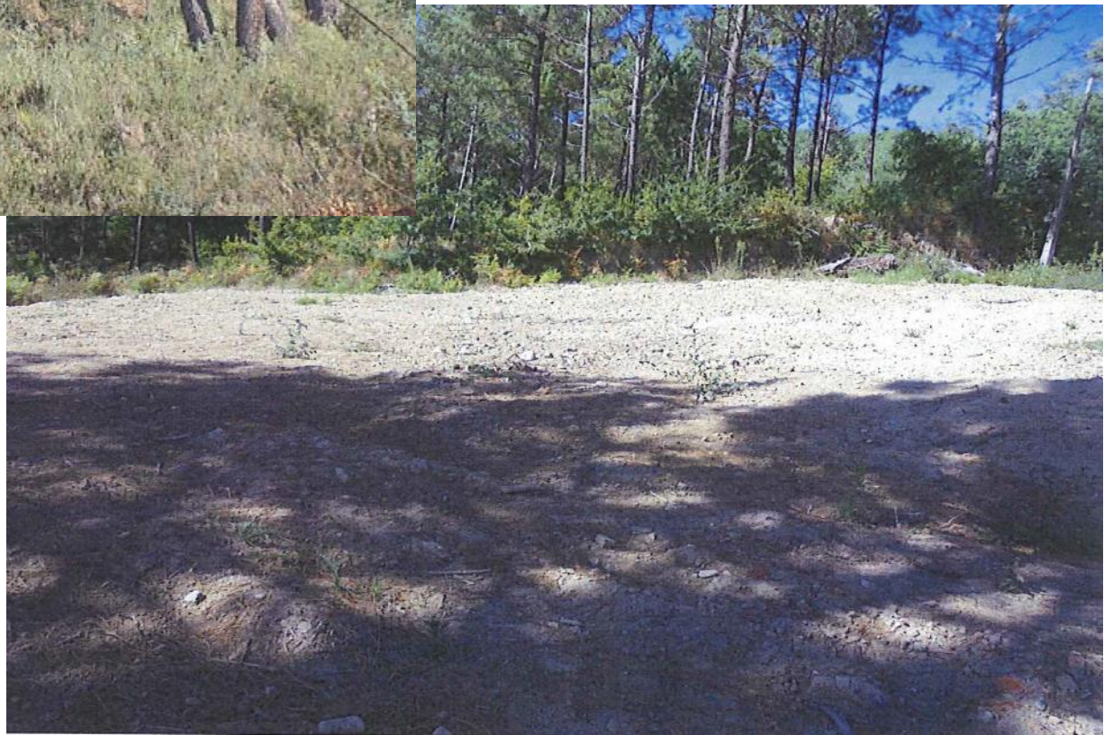
despois da demolición
