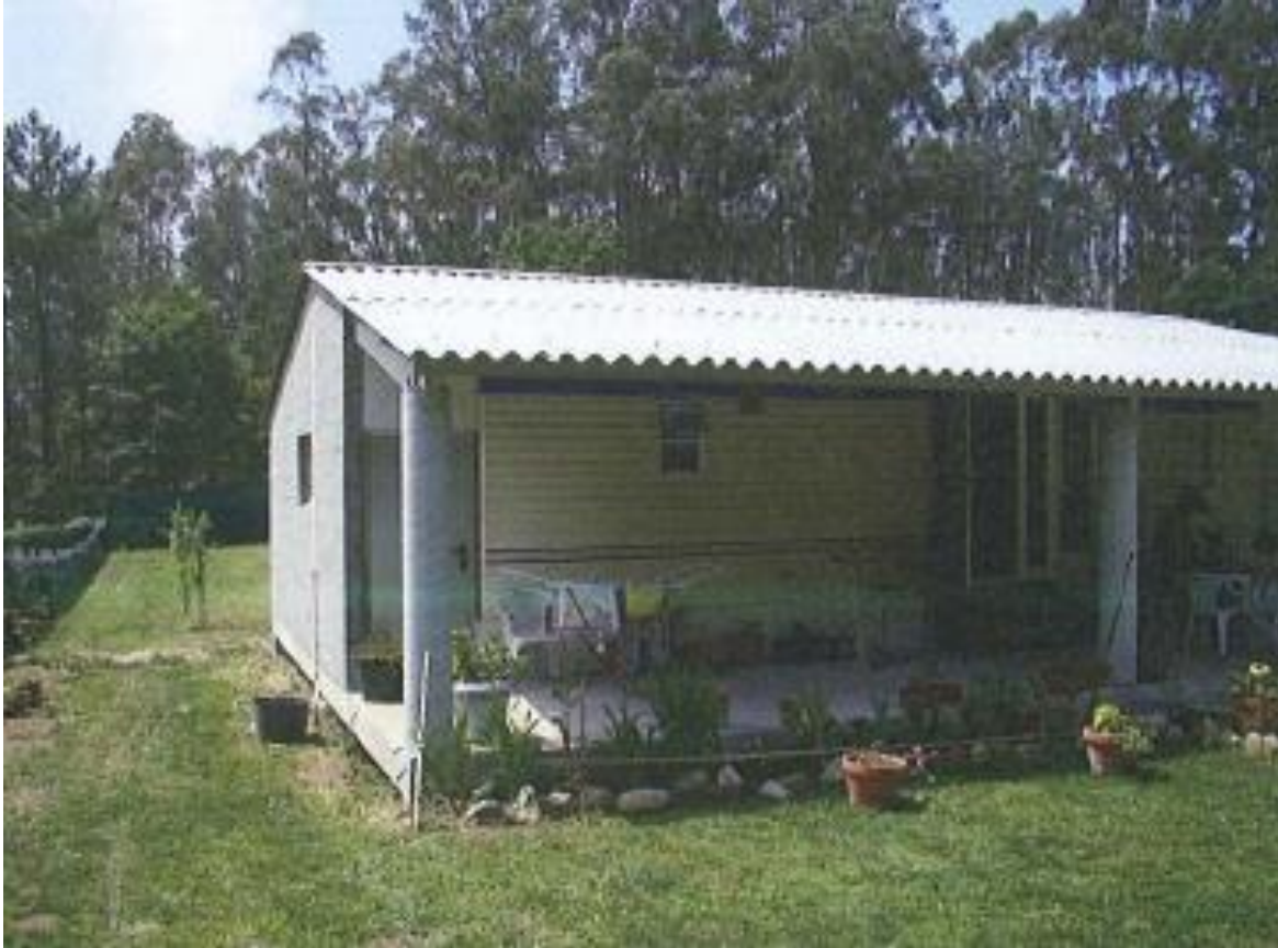
antes da demolición
