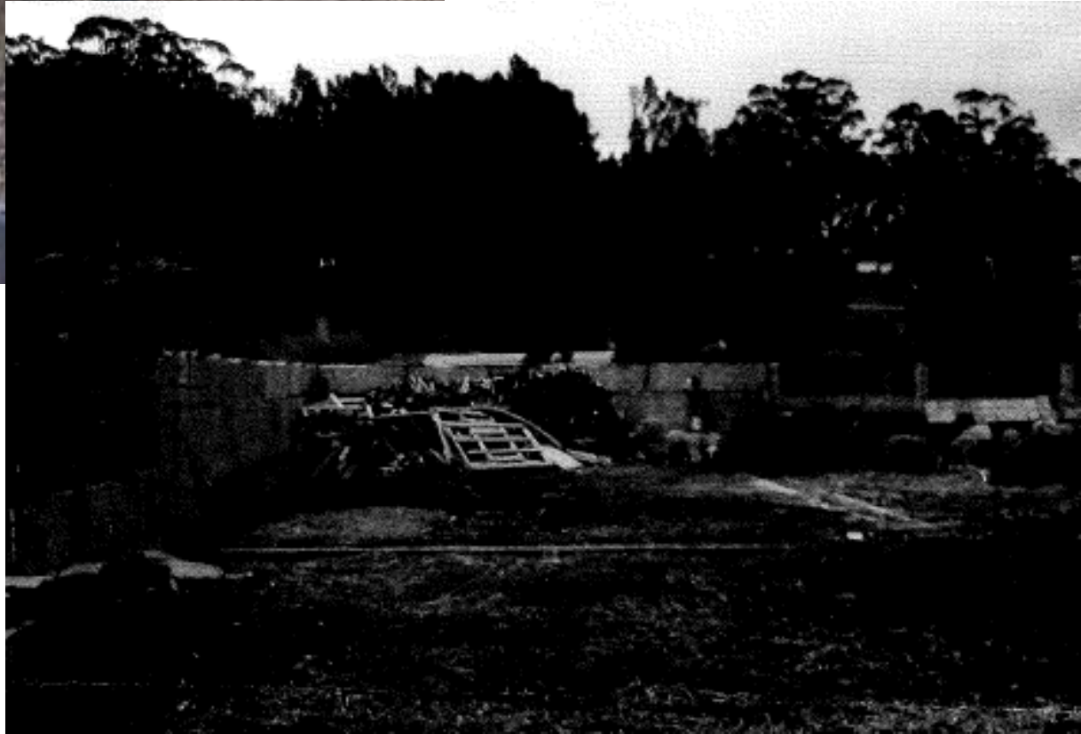
despois da demolición
