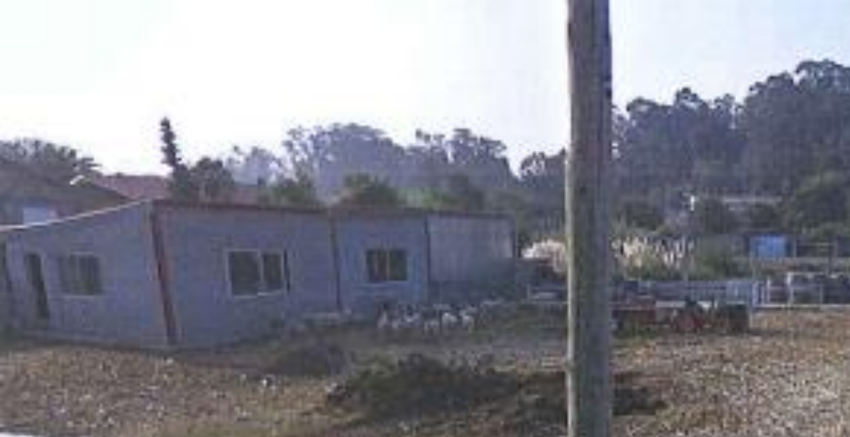
antes da demolición
