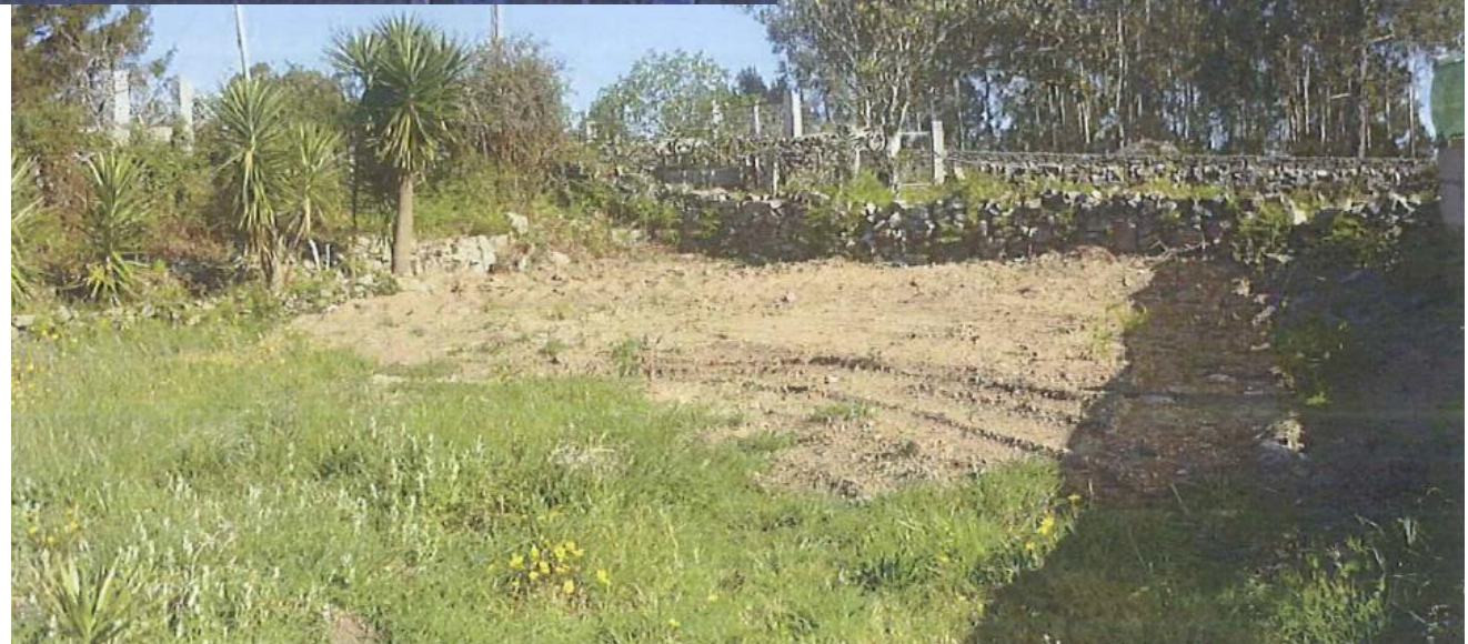
despois da demolição
