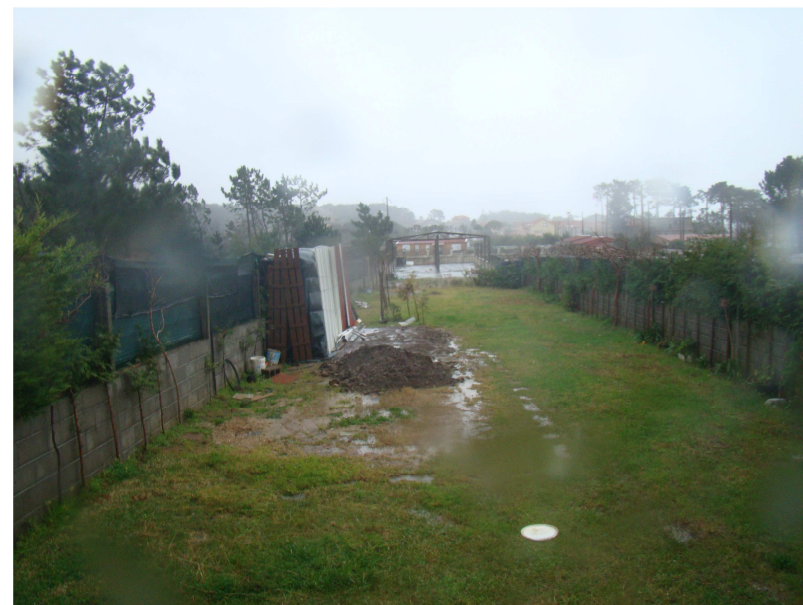
Despois da demolición
