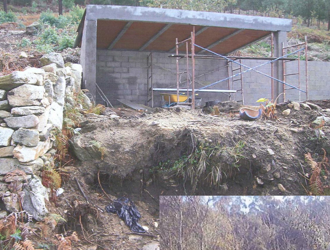
antes da demolición
