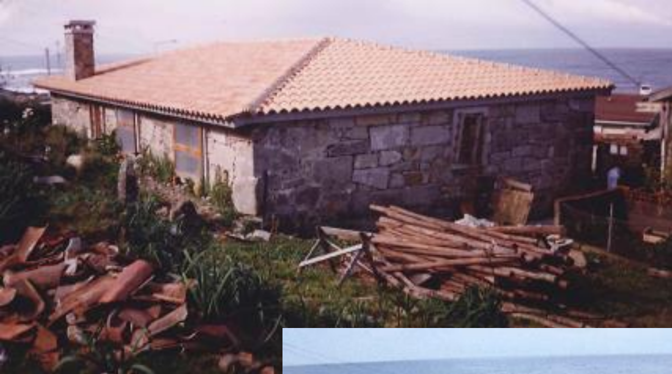
antes da demolición
