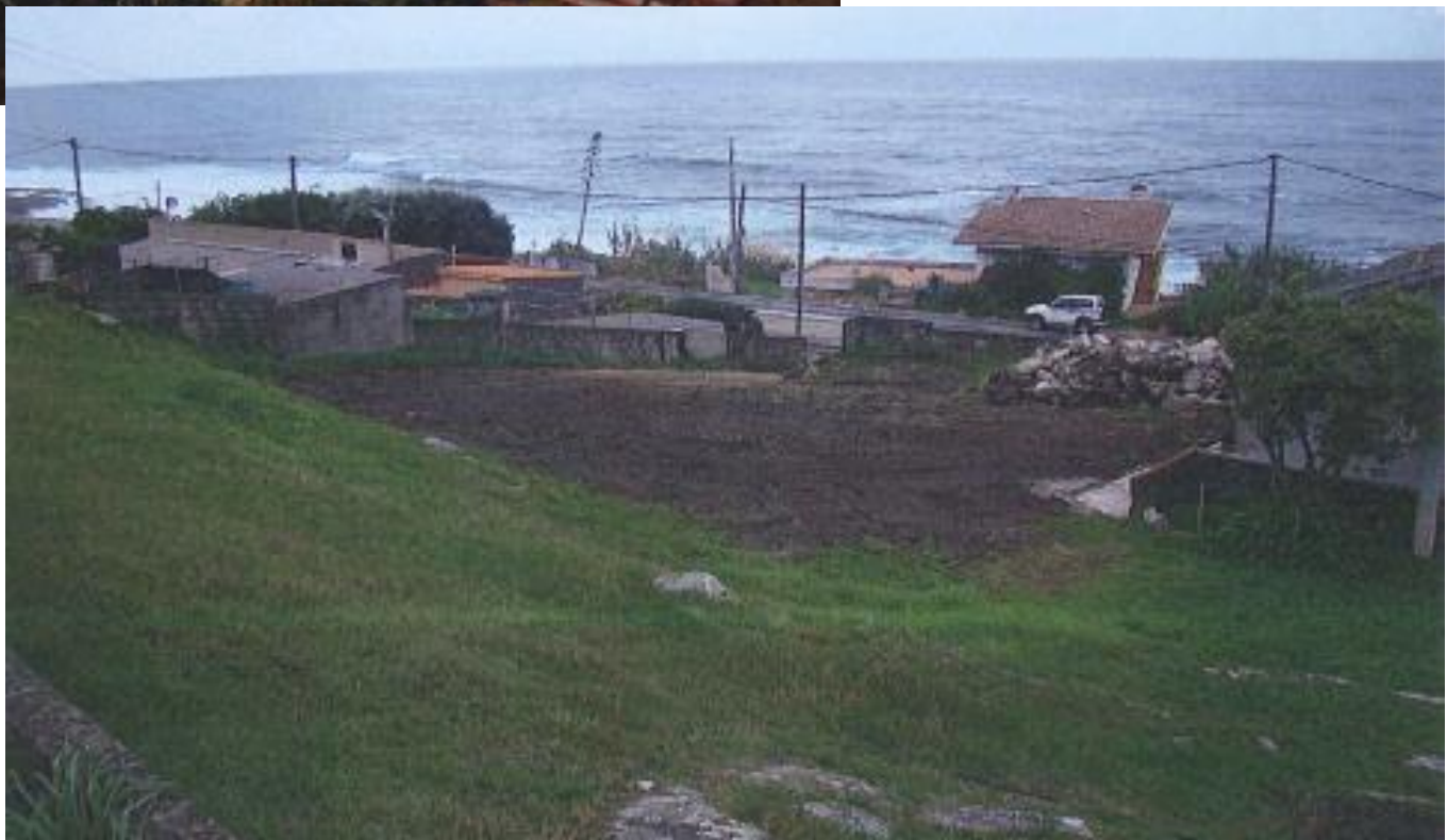
despois da demolición
