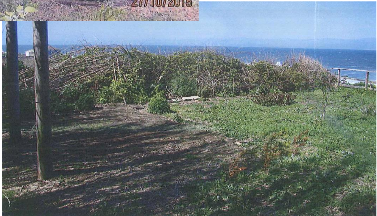
despois da demolición
