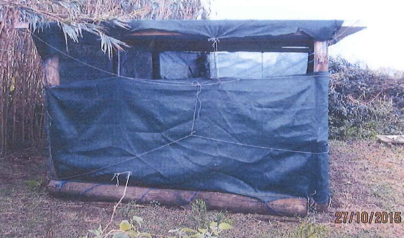
antes da demolición
