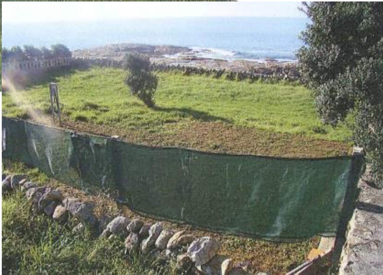
despois da demolición
