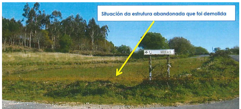
Despois da demolición
