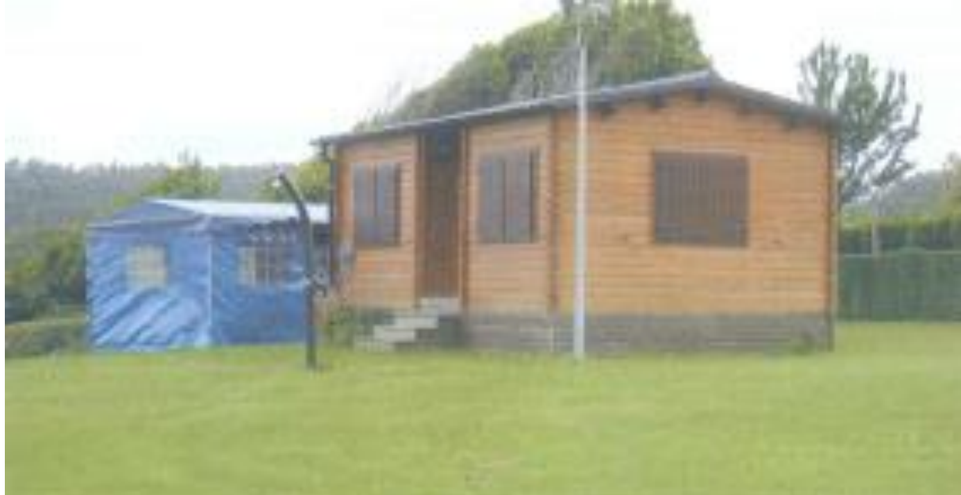
antes da demolición
