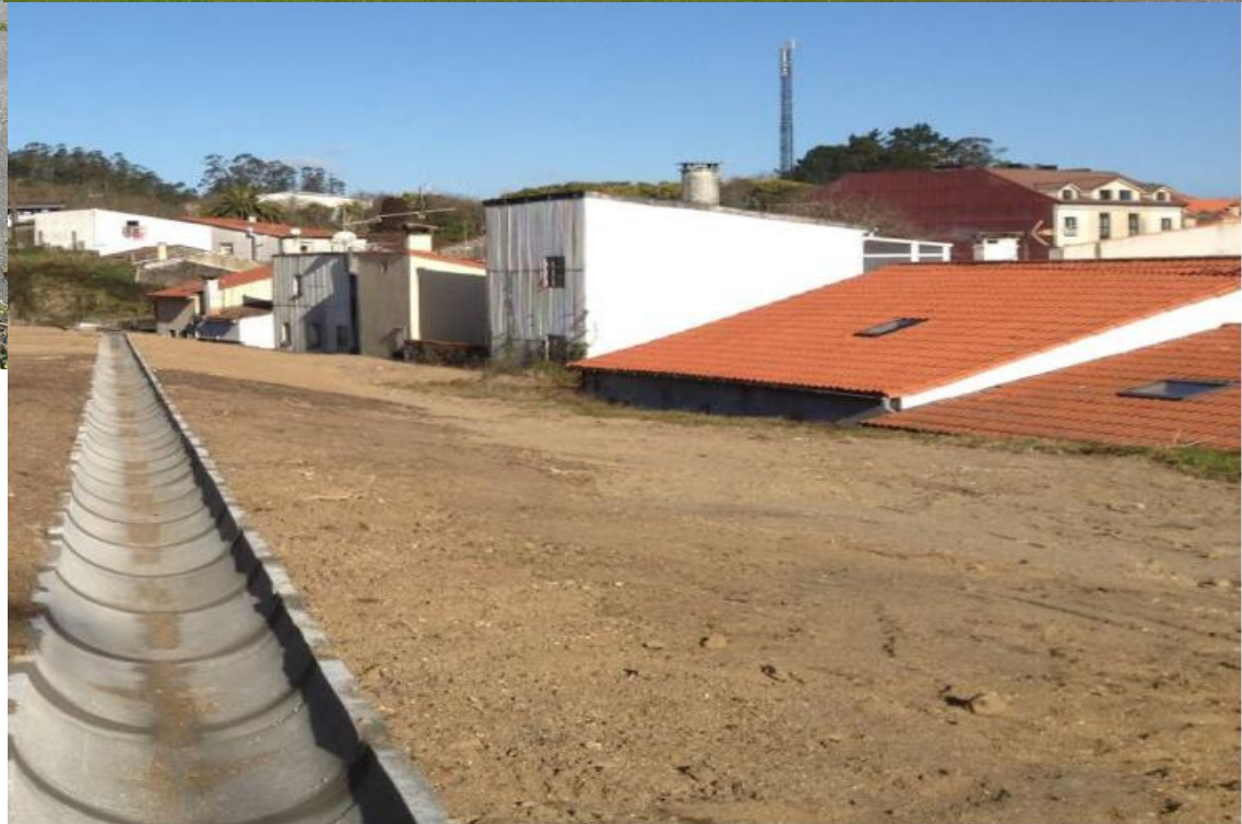
despois da demolición
