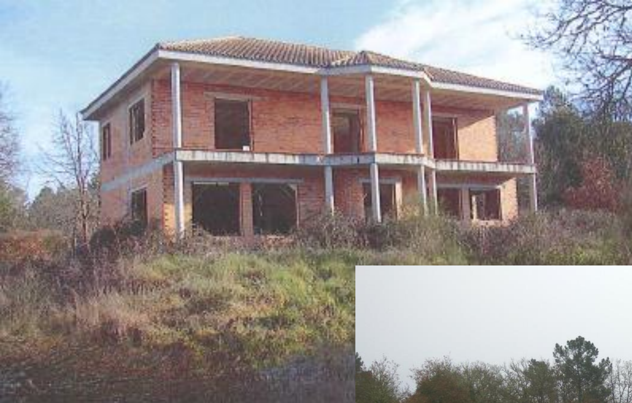
antes da demolición
