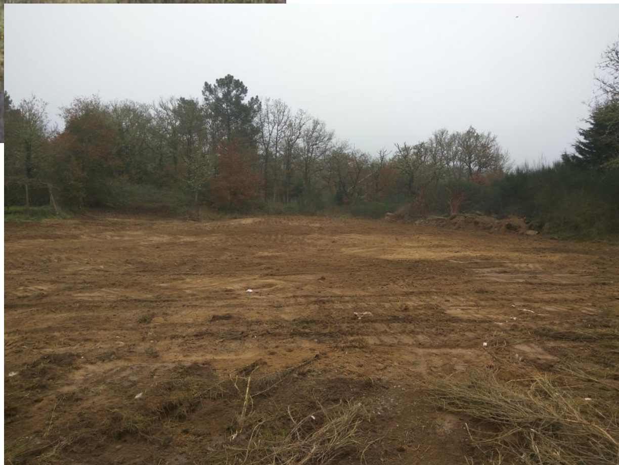
despois da demolición
