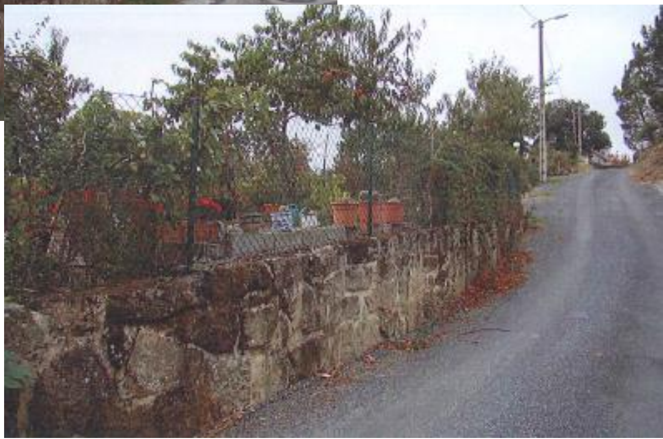
despois da demolición
