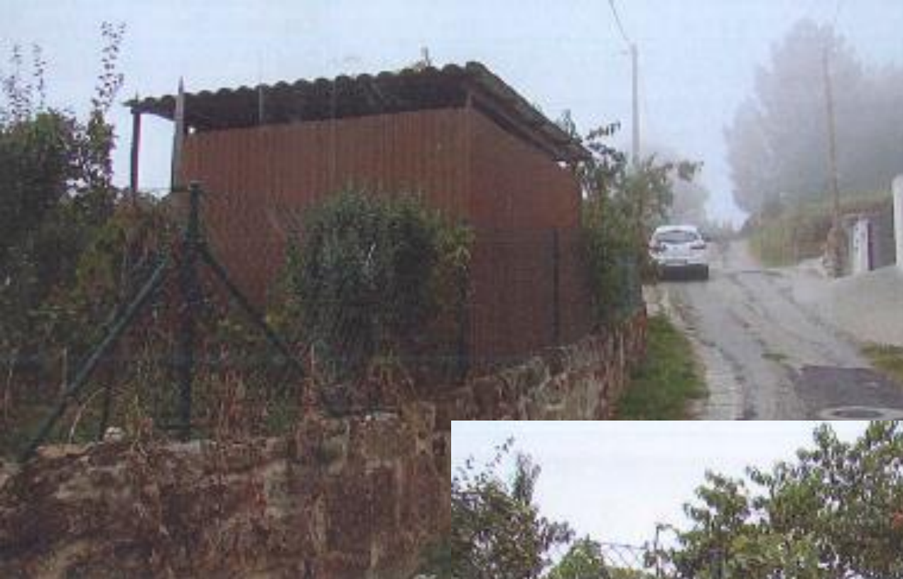
antes da demolición
