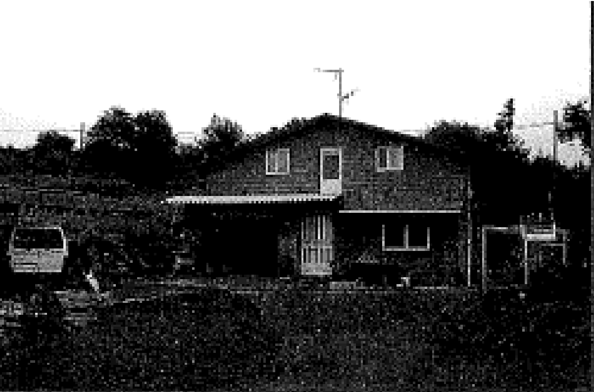
antes da demolición
