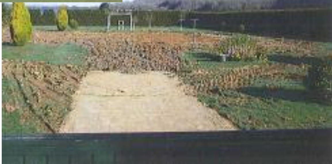
despois da demolición
