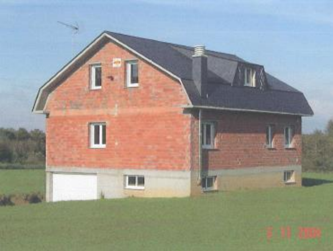
antes da demolición
