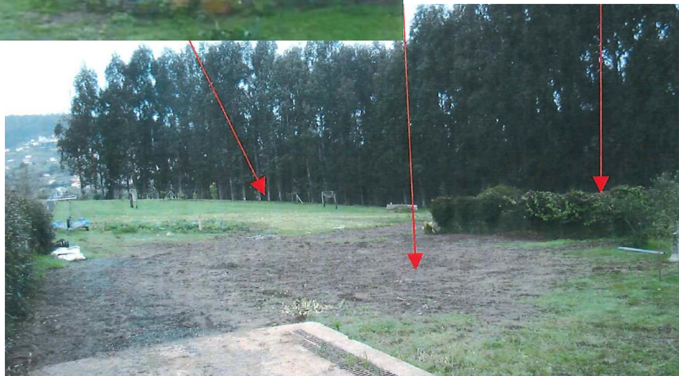
despois da demolición
