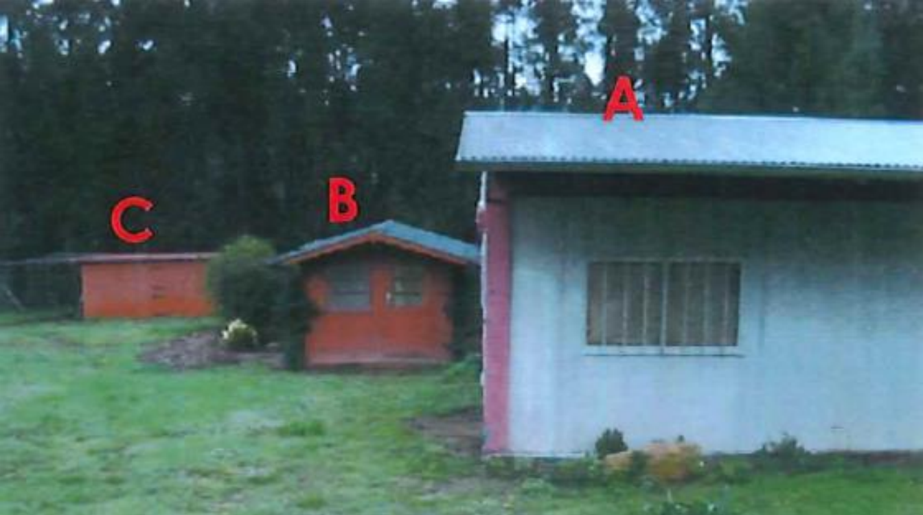
antes da demolición
