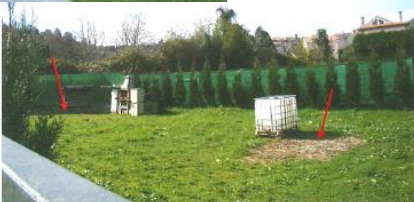
despois da demolición
