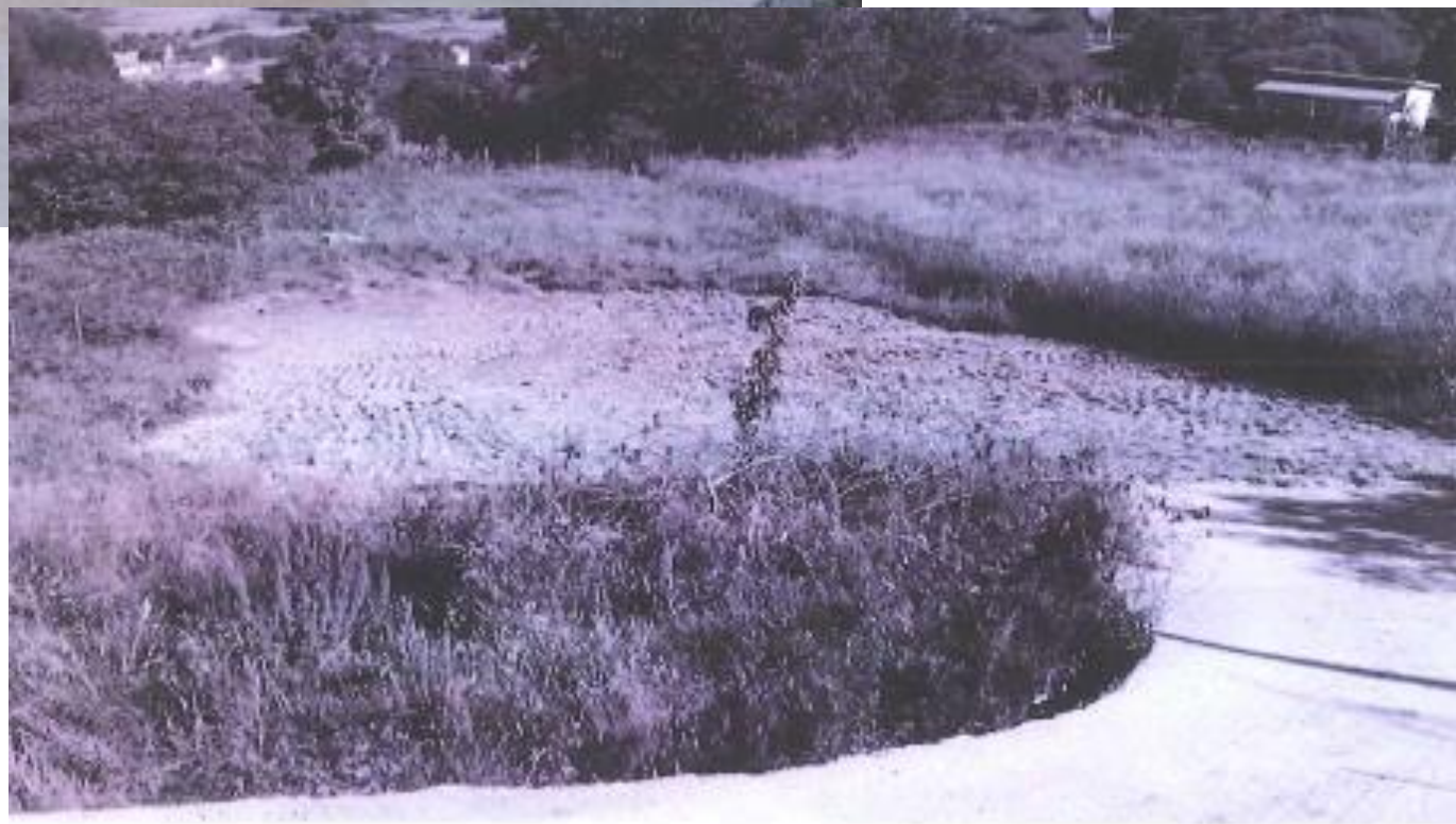
despois da demolición
