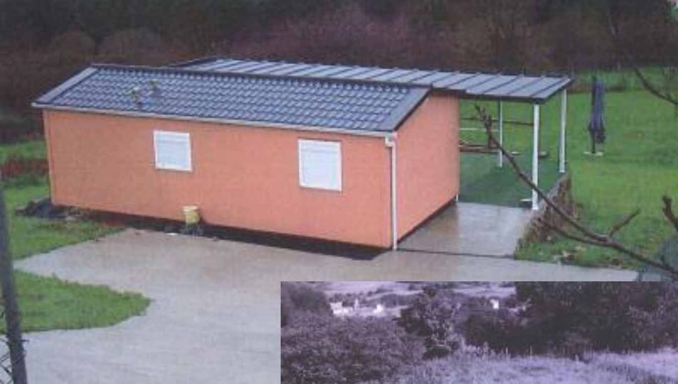
antes da demolición
