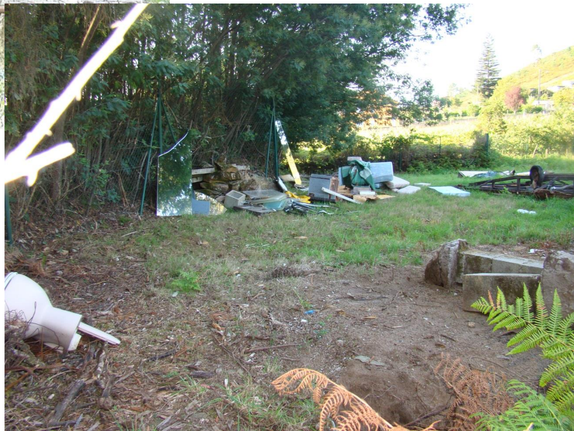
despois da demolición
